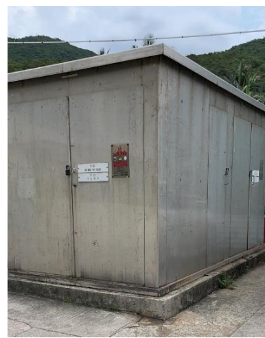
由港燈提供的預製組件式變壓器配電箱
